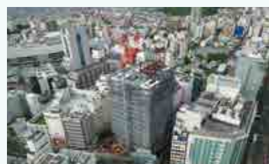
建設中のM20(’23年7月時点)
